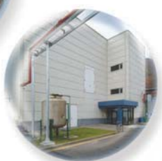
製剤棟(上田工場)
